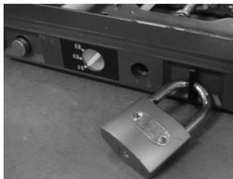
注：必须先将手柄从位置切换孔中抽出方可将位置锁定拉杆拉出。
